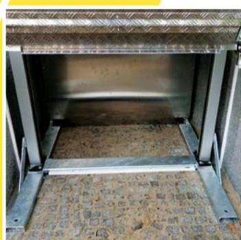
Der Carrier PICCO steht solide ohne bauseitige Vorarbeiten – die Rampe ist entweder acht Zentimeter hoch oder liegt ebenerdig mit einer zehn Zentimeter eingelassenen Unterfahrt.
