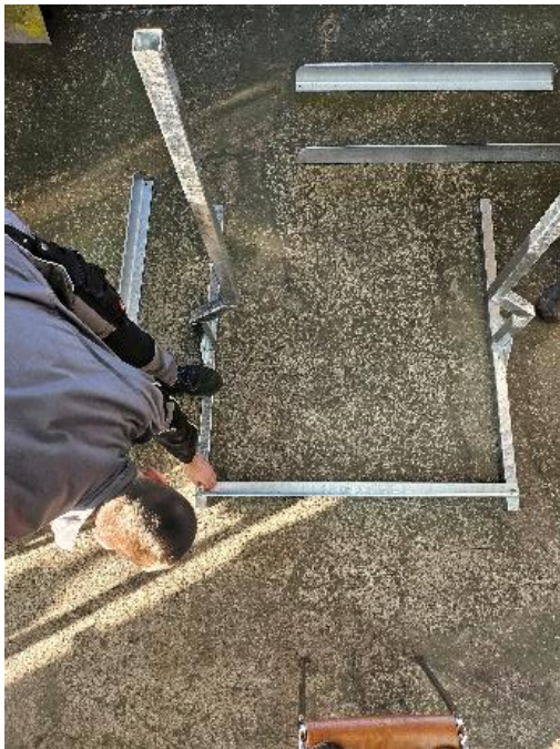
L-Winkel ansetzen und handfest verschrauben
